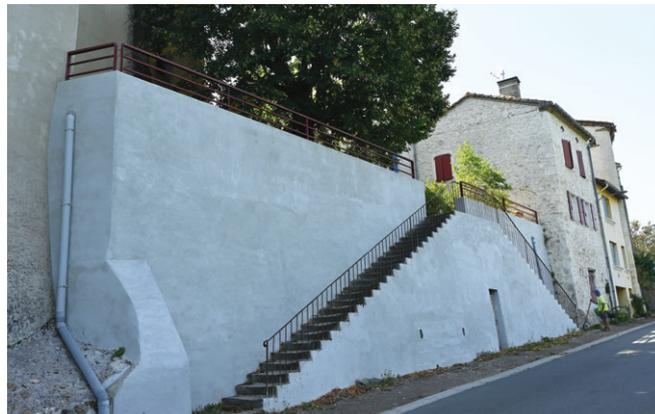
Pour sécuriser la voirie, deux murs de soutènement ont été construits. Le mur du cimetière a été nettoyé. Les travaux de crépis du mur de l'escalier ont été réalisés. Les travaux de végétalisation du talus sont en cours d'étude.
