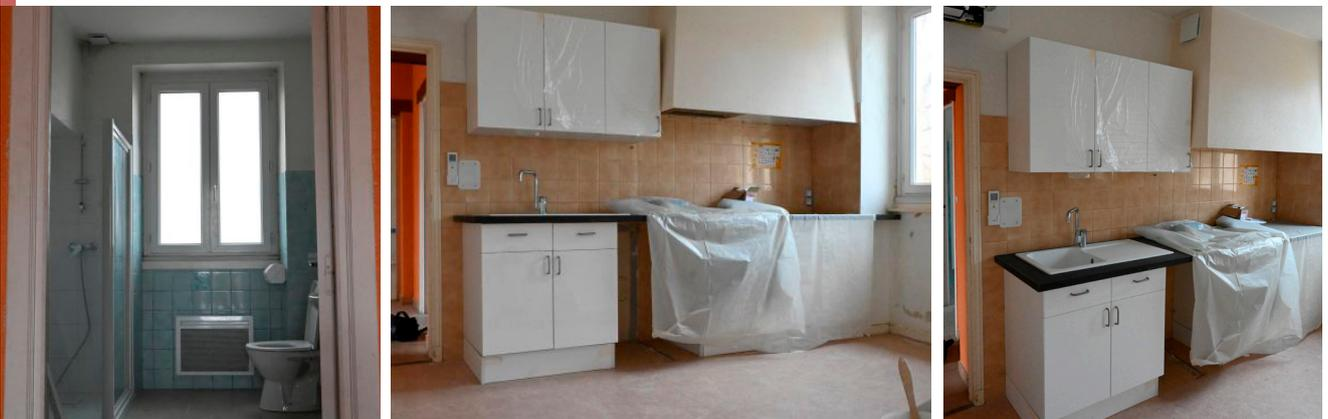
Les travaux de finition sont en cours : ce logement a été totalement refait avec une nouvelle salle d'eau avec cabine douche, une cuisine équipée, un chauffage climatisation par pompe à chaleur.
